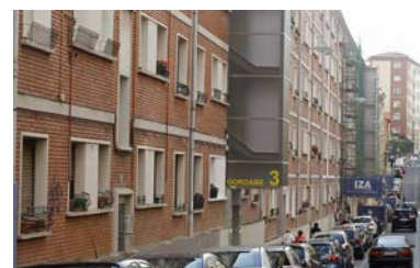
Imagen 16: Calle del barrio de la Milagrosa con la rehabilitación tipo de extracción de escaleras a la calle para la instalación de ascensor que se está llevando a cabo en la mayoría de sus edificaciones.
